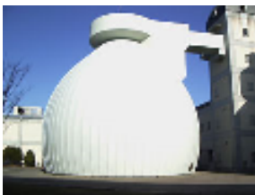
下水汚泥をメタン発酵させるための金沢市の卵形消化タンク
